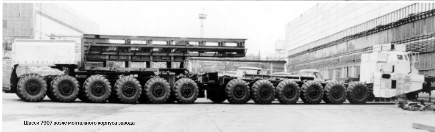
Шасси 7907 с массово-габаритным макетом ТПУ на полигоне УТБС под Минском. Сентябрь 1996 г.
